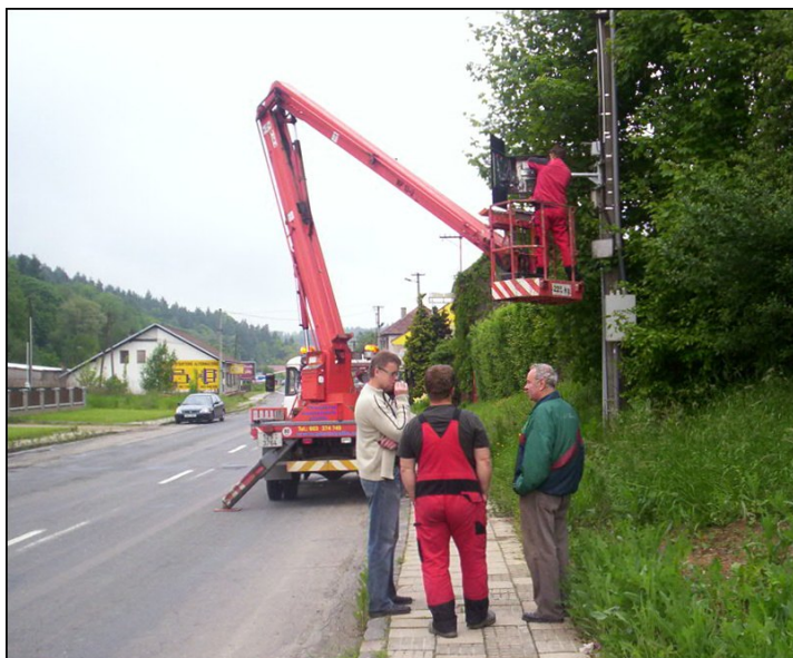
Montáž radaru. Foto VP
