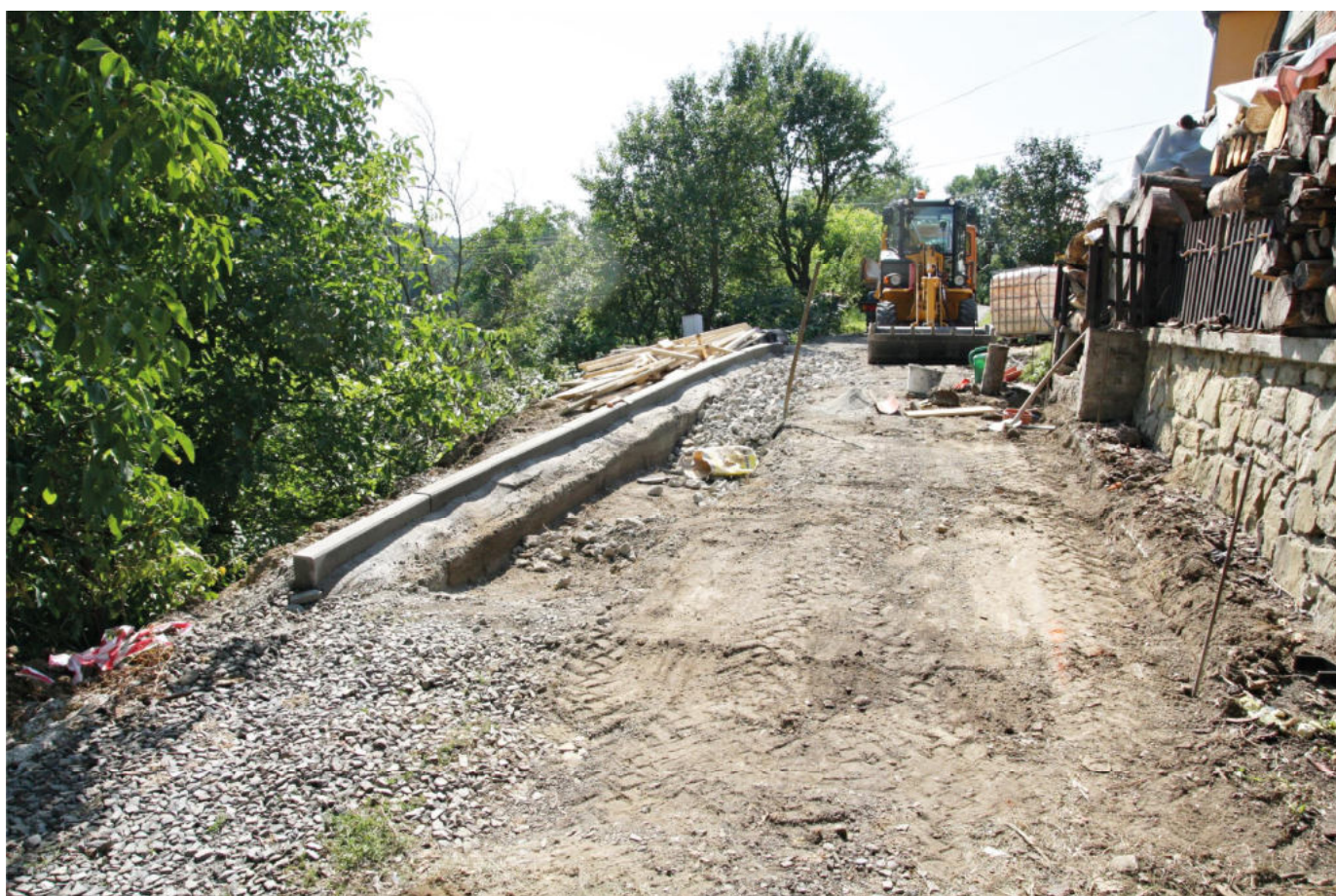
Průběh rekonstrukce komunikace v části obce „Na kopci“ /foto VK
