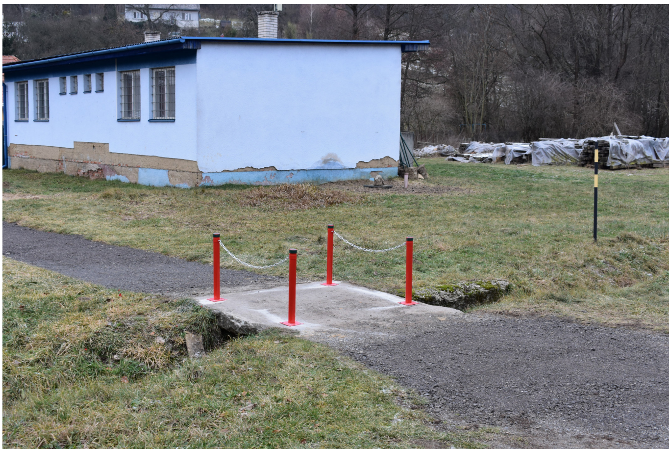
Mostek u šaten a provizorně upravený chodník
