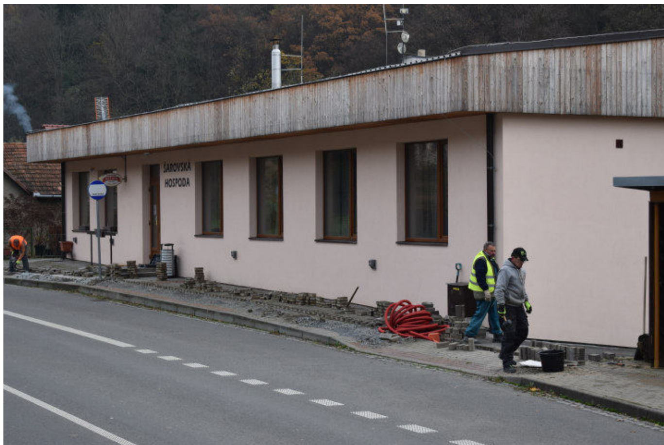
Pokračovaly práce na uložení kabelů vysokorychlostního internetu
